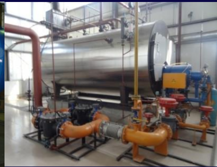
生物质燃烧器和燃气蒸汽锅炉
